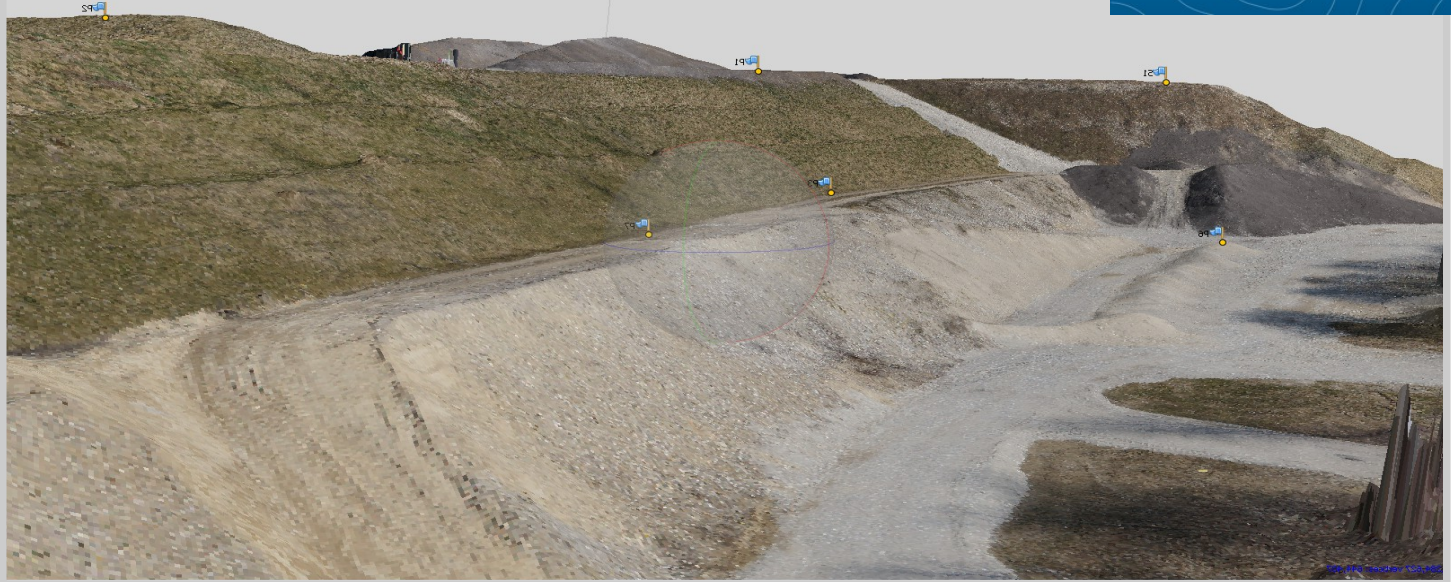
Kiesgrube. Texturiertes Mesh, direkt abgeleitet aus hochdichter Punktwolke
